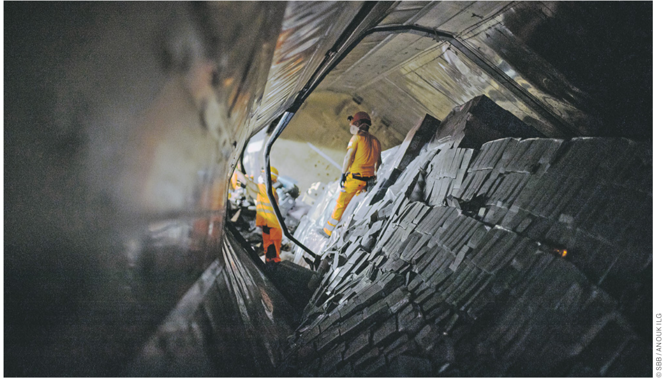
Im Tunnel bei 40 Grad zu arbeiten ist eine grosse physische Belastung.
