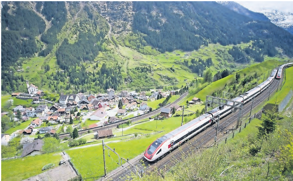
Der Inbegriff der Gotthard-Bergstrecke: Die Kirche von Wassen, die dank der Kehrtunnel dreimal ins Blickfeld der Passagiere kommt.
