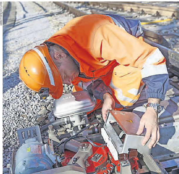
Ein Monteur von Infra IH arbeitet an einem Weichenmotor.
