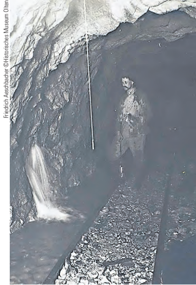
Wasser ist der grosse Feind bei Tunnelbauarbeiten im Jura.
